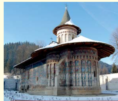
Fig. 6. Biserica Mănăstirii Voroneț, ctitorie a lui Ștefan cel Mare, construită în anul 1488
