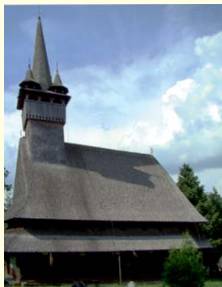
Fig. 7. Biserica din lemn de la Budești, construită în 1643
